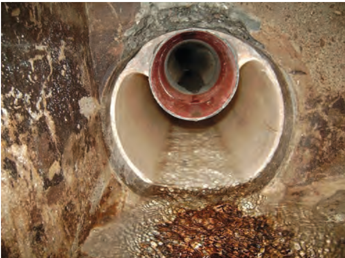
Einbau des SoltaLiner Xtra 2 in 1 im Rahmen einer Sanierung unterhalb eines Schwimmbeckens in der Schweiz. Im Hauptrohr DN 400 entschied man sich für die Sanierung mit einer 150 mm Xtra-Sektion im Liner.
