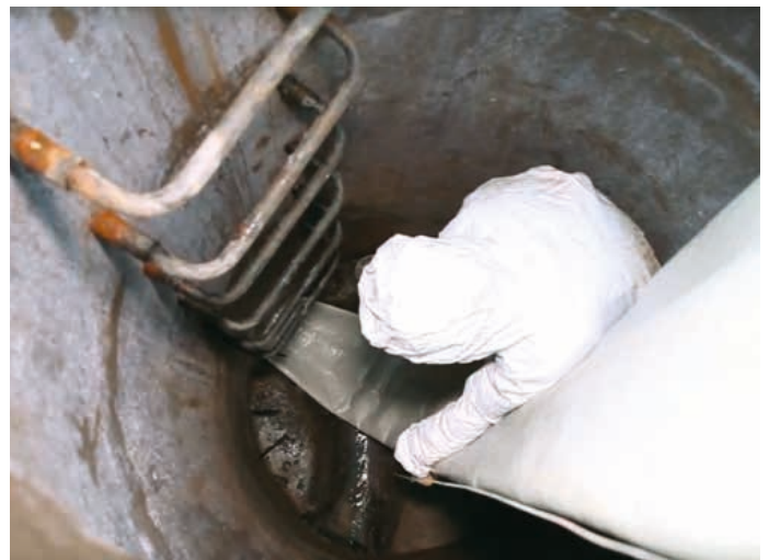
Einbau des SoltaLiner Xtra 2 in 1 im Rahmen einer Sanierung unterhalb eines Schwimmbeckens in der Schweiz. Im Hauptrohr DN 400 entschied man sich für die Sanierung mit einer 150 mm Xtra-Sektion im Liner.
